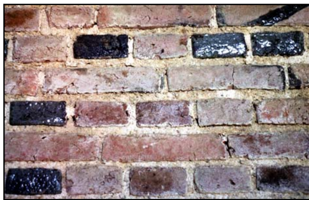
Briques de la Grand'Maison, identiques à celles de l'église de Chenusson
